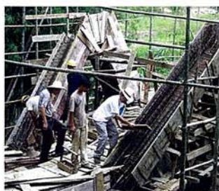
桥墩模板安装
