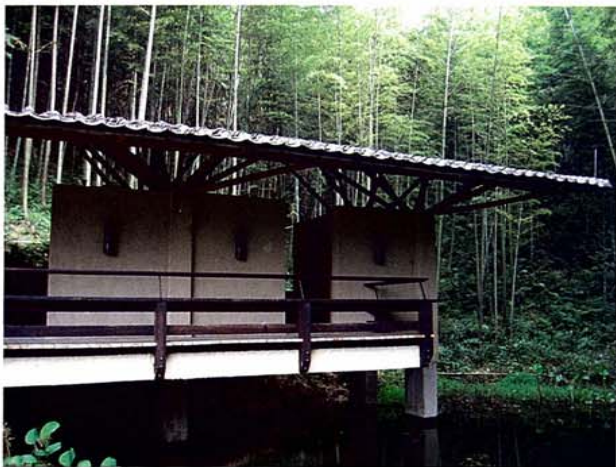
入口接待处卫生间，架空在水面上，室内有窗户面向竹林
