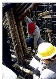
竹子吊柱安装
